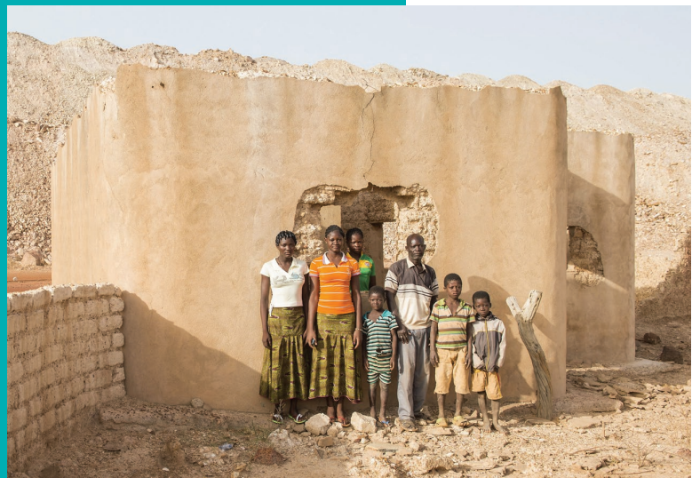
Eine Familie in Burkina Faso vor ihrem zerstörten Haus: Für den Bau einer Goldmine wurde das ganze Dorf umgesiedelt.
